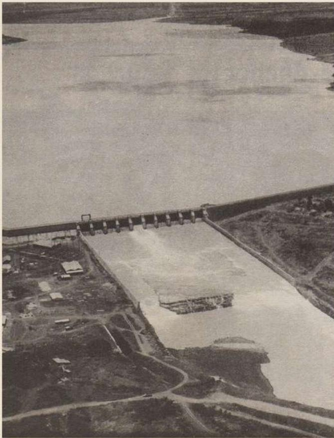
Foto da Usina Hidrelétrica de Cachoeira Dourada-Go, Vertedores para 800 metros Cúbicos por Segundo.
