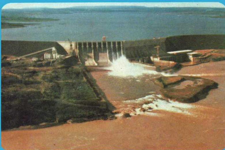
Comportas do Vertedor em Fase de Teste
