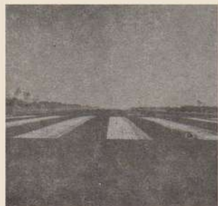
Cabeceira da Pista do Aeroporto de São Simão, que mede 1.780m. toda asfaltada e construída pela CEMIG.
